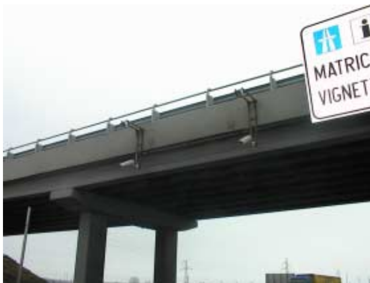
48. ábra: videokamerás ellenőrző pont [47]
